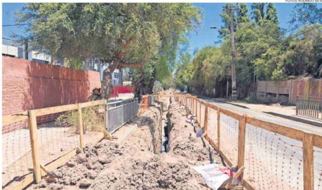
SEGÚN NUEVA ATACAMA LAS OBRAS EN EL CALLEJÓN PEDRO LEÓN GALLO ENTRE LEONIDAS PÉREZ Y LOS CARRERA ESTÁ EN 75% DE AVANCE A LA FECHA.
