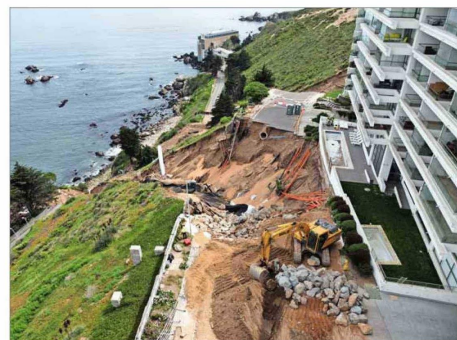
OBRAS. — Ya se han vertido más de mil metros cúbicos de material de relleno sobre el segundo socavón que surgió frente al condominio Miramar.
