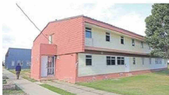
El actual edificio del pensionado.
