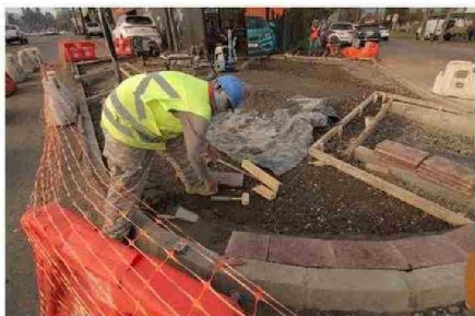
A TODA MÁQUINA SE REALIZAN LOS TRABAJOS EN TEMUCO.
