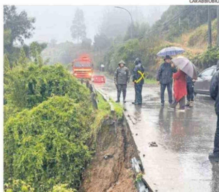
UN DESLIZAMIENTO DE TIERRA AYER EN LA REGIÓN DEL BIOBÍO.
