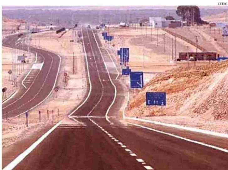
EL TRAMO CALDERA-ANTOFAGASTA CONTEMPLA UNA EXTENSIÓN DE 466,2 KMS.
