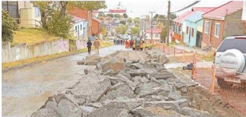
Con el retiro del pavimento dañado en calle Bellavista, entre Avenida España y Almirante Señoret, se iniciaron las obras de reposición del deteriorado paño de dicha calzada.
