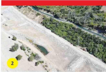
DOH del MOP protege Canal Melado en la Provincia de Linares
