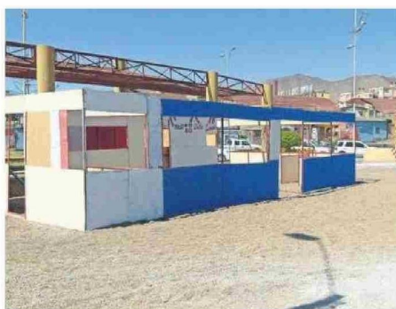
CUANDO LAS RAMADAS SE INSTALARON EN PLAZA DE LOS EVENTOS.
