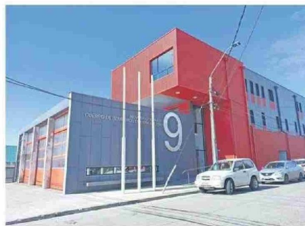
A través de proyectos complementarios se terminarán los portones automáticos, sistema de extracción de gases, entre otros.
