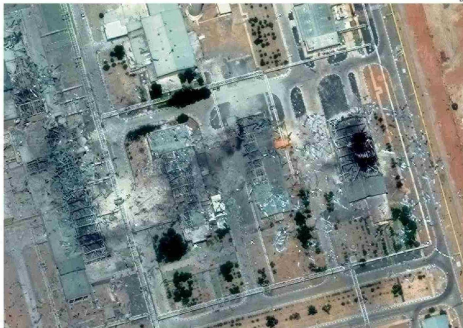
EL MISMO DÍA DEL ATAQUE ESTADOUNIDENSE QUEDÓ EN EVIDENCIA QUE GRAN PARTE DE LAS INSTALACIONES HABÍAN SIDO ARRASADAS.
