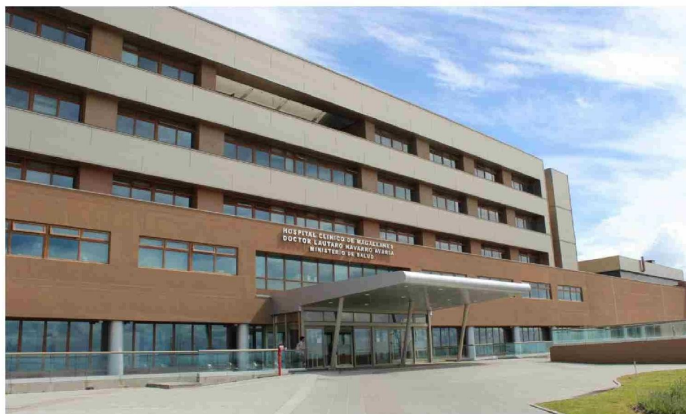
En el Hospital Clínico de Magallanes falleció el trabajador luego de sufrir la caída de altura.
