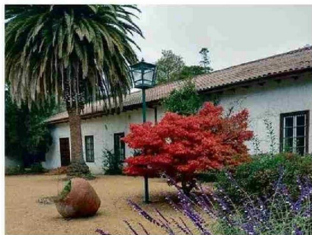
LA CASONA DEL PARQUE SUFRIÓ GRAVES DAÑOS CON EL TERREMOTO DEL 27 DE FEBRERO DE 2010.
