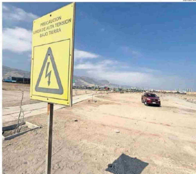
ENTRE LOS PELIGROS, ESTÁN LINEAS DE ALTA TENSION QUE SUPONDRÍA UN PELIGRO PARA LA CENTE.
