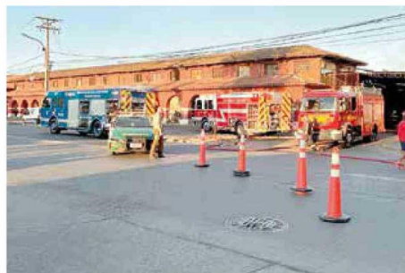
Tres locales comerciales del Crea de Talca, resultaron afectados por el incendio que fue provocado por la quema de pastizales.
