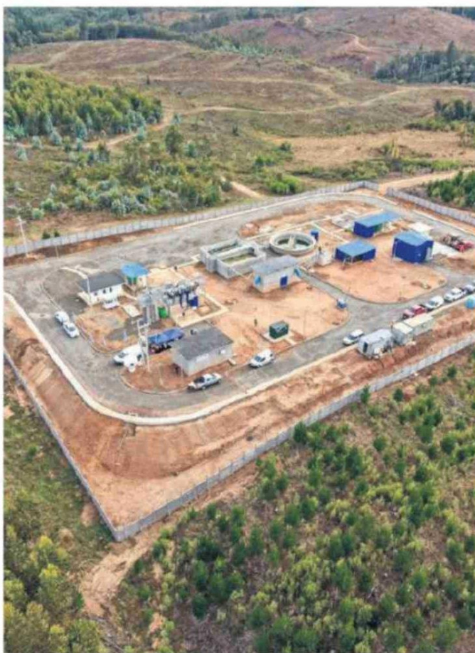
Las obras restantes están a cargo del municipio de Tomé.
