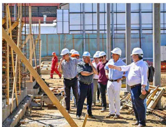
Las obras de mejoramiento del Patio Isabel Riquelme presentari un 25% de avance.
