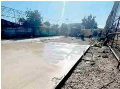
Ya se está trabajando en la multicancha Santa Lucía, para alegría de los vecinos.
