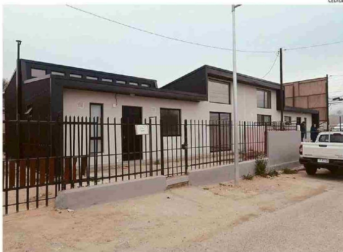
EN CANAL CHACAO ESTÁN CERCA DE ENTREGAR CASAS Y EN VALLE EL MONTE REGISTRAN AVANCES.
