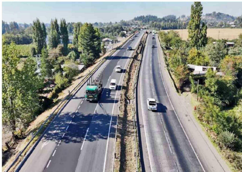
Plan contempla además el despliegue de equipos de emergencia en rutas interiores.
