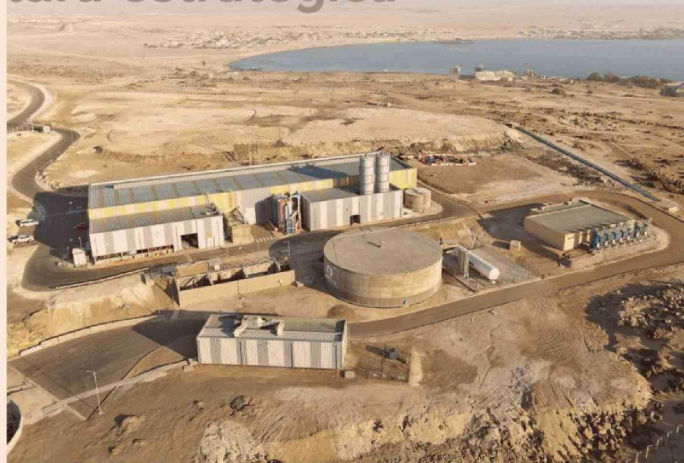
Planta Desaladora de Nueva Atacama en Caldera.
