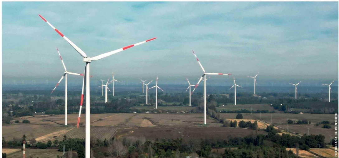
EL PARQUE EÓLICO RINCONADA contempla una inversión cercana a los USD 365 millones y se emplaza entre las comunas de Laja y Los Ángeles.
