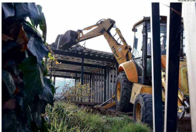
CON RETROEXCAVADORA SE INICIÓ EL PROCESO PARA DESMANTELAR LOS CIMIENTOS DE 4 CASAS.
