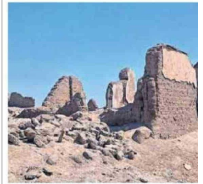
LOS EFECTOS DEL TERREMOTO FUERON CATASTRÓFICOS.
