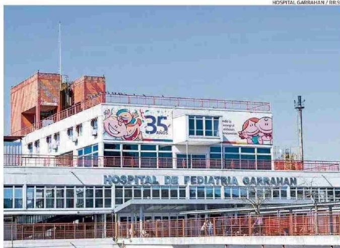
EL HOSPITAL FUE FUNDADO EN 1987 COMO CENTRO PEDIÁTRICO DE ALTA COMPLEJIDAD.
