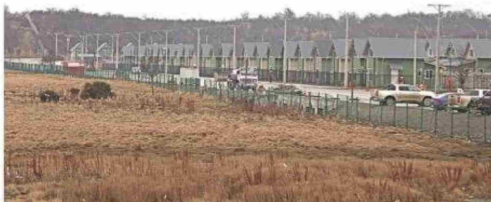
Actualmente se trabaja en la conexión al alcantarillado y obras de urbanización de los proyectos "Brisas del Estrecho I y II".
