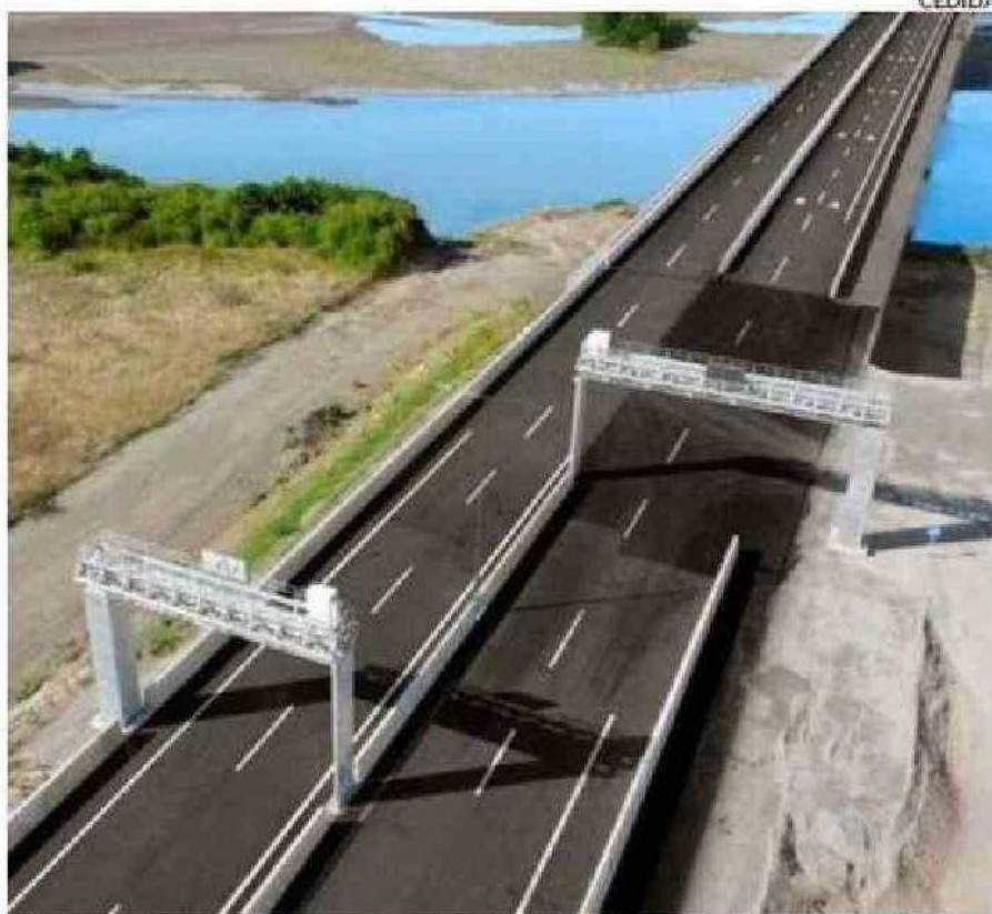
El viaducto une las comunas de San Pedro de la Paz y Hualpén.
