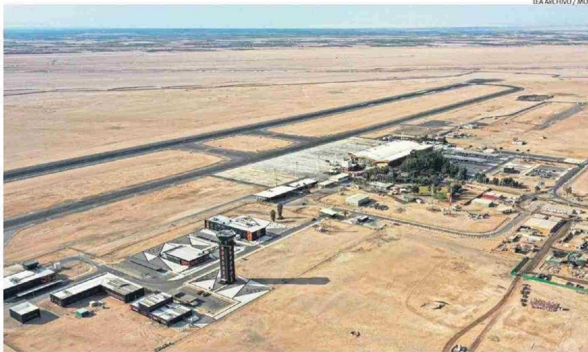
LA ACTUAL INFRAESTRUCTURA DEL AEROPUERTO CHACALLUTA.
