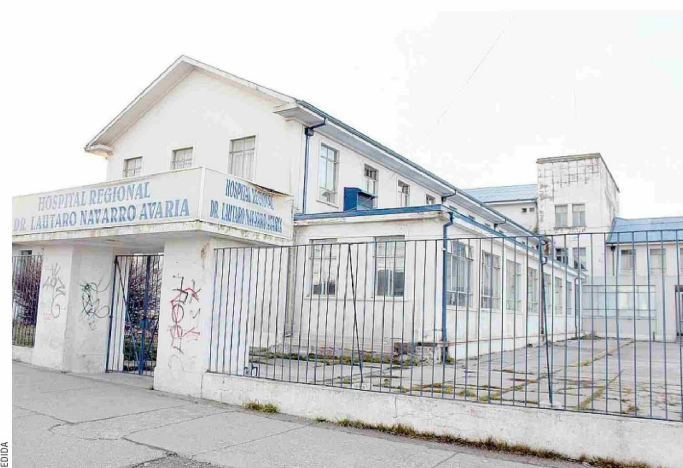
El ex Hospital Regional se encuentra a un paso de poder ser demolido tras años de abandono.
