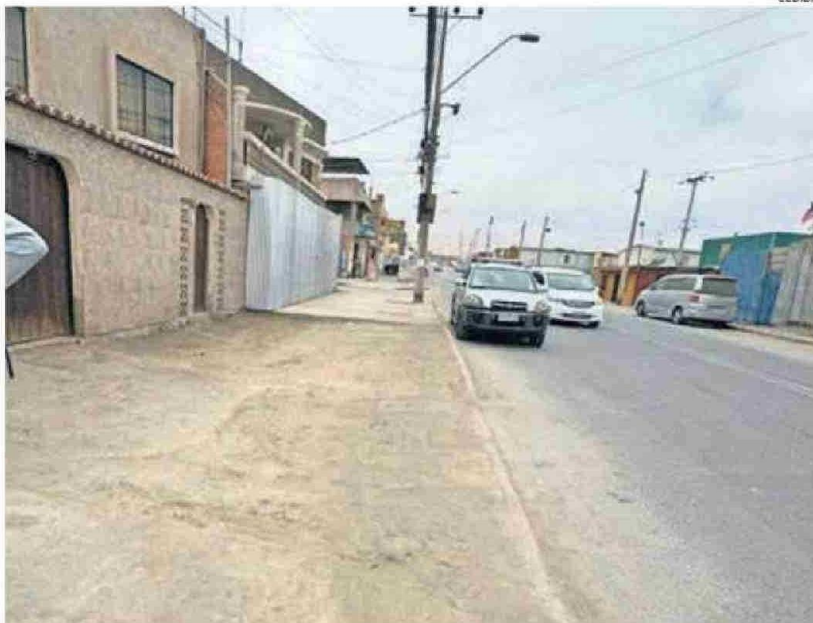
LA EJECUCIÓN DE ESTOS TRABAJOS SE PROYECTAN PARA EL SEGUNDO SEMESTRE DE 2026.
