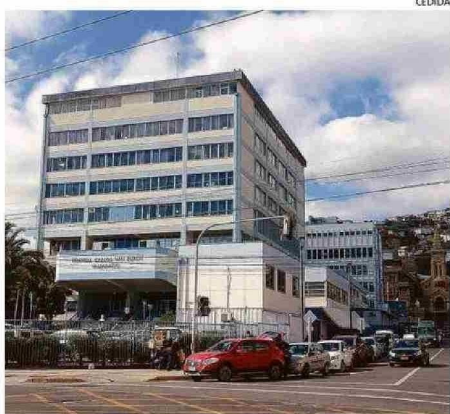
EL RECINTO REQUIERE URGENTEMENTE DE UNA AMPLIACIÓN.
