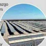
La planta, desarrollada por Contour Global, tiene una capacidad de 221 MWp y un sistema de baterías de 1.2 GWh, permitiendo suministrar 200 MW durante 6.2 horas después del ocaso. Esto garantiza energía solar estable incluso de noche y facilita la inyección de excedentes al mercado.
