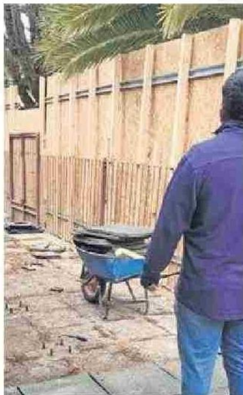
TRABAJOS EN LA POSTA.
