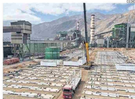
EL PROYECTO CUENTA CON EL 50% DE LAS BATERÍAS MONTADAS.
