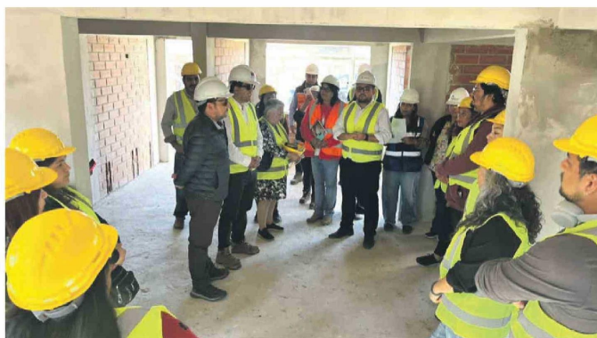
Tras la publicación de supuestos problemas las autoridades del SERVIU y municipio de Los Vilos junto a los beneficiados recorrieron ayer las obras del loteo "Última Esperanza".
