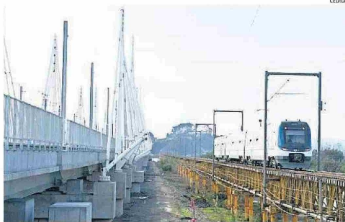
BIOTREN ATRAVESANDO EL BIOBÍO SOBRE EL ANTIGUO PUENTE, A LA IZQUIERDA, EL NUEVO VIADUCTO.
