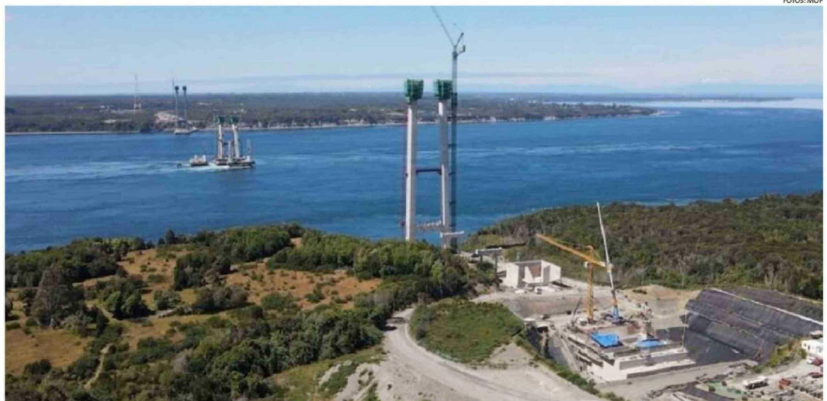
EL PUENTE PRESENTA UN AVANCE CERCANO AL 63%. LAS AUTORIDADES DEL NUEVO GOBIERNO YA PROYECTAN UNA VISITA PARA CONOCER SU PROGRESIÓN.
