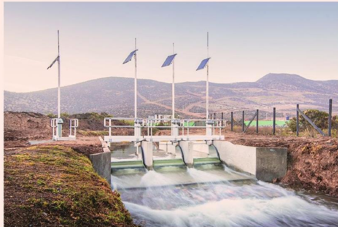
Compuertas de Rubicon para la gestión del recurso hídrico, instaladas para la Asociación de Canallistas del Canal Bellavista. Proyecto Bellavista-Ceres, Región de Coquimbo.
