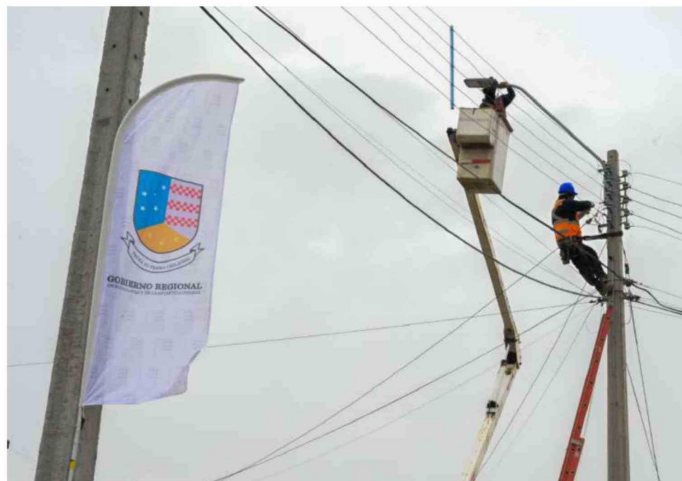
Autoridades regionales y comunales dieron inicio al proyecto de recambio de luminarias que permitirá modernizar el sistema de alumbrado público con tecnología LED en la comuna.
