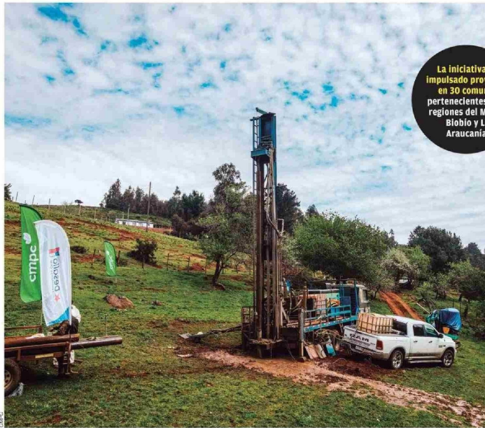
Construcción del sistema APR en Collipulli.
