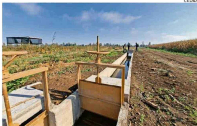
OBRAS ESTÁN ACTUALMENTE EN EJECUCIÓN.
