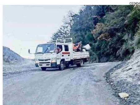
LAS CUADRILLAS TRABAJARON ANTES DE LA LLEGADA DEL FRÍO.
