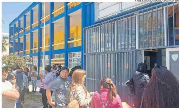
INFRAESTRUCTURA DEL LICEO COMERCIAL SIGUE SIENDO UN PROBLEMA.
