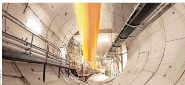
Las tecnologías desarrolladas por Bekaert permiten mayores niveles de resistencia, reducción de tiempos constructivos y mejoras en seguridad operacional en infraestructura subterránea.
