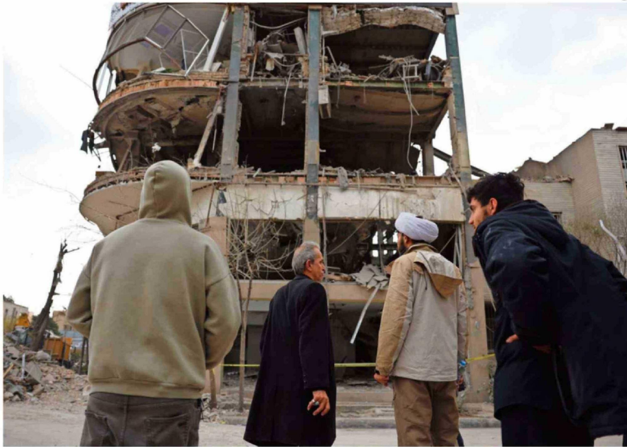
EDIFICIO EN TEHERÁN DONDE FUNCIONABAN MEDIOS DE COMUNICACIÓN ALCANZADO POR BOMBARDEO.
