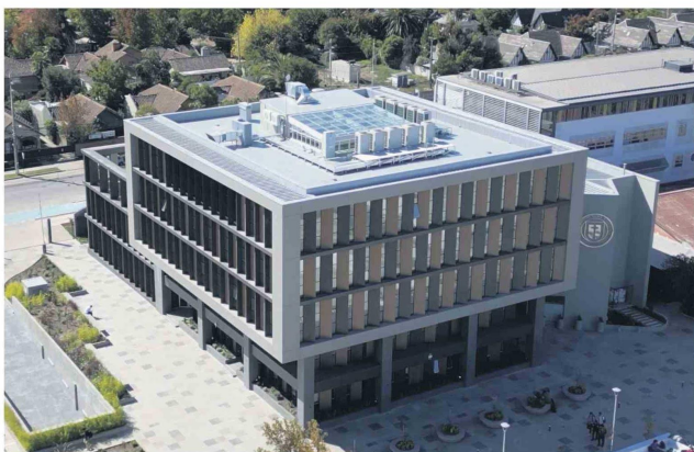
Edificio Facultad de Ciencias Básicas , que alojará al Planetario, recientemente aprobado por el GORE Maule, con una inversión superior a los 3.500 millones de pesos.
