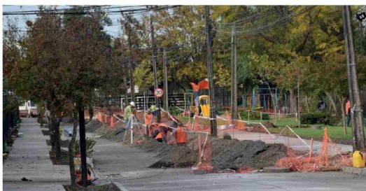
VECINOS VALORARON el ritmo de los trabajos, que incluso podrían concluir antes del plazo originalmente contemplado.
