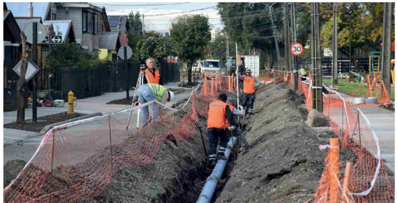
AVANZAN LAS FAENAS de hormigonado en Avenida Costanera Quilque Norte, obra que busca mejorar la conectividad y seguridad vial del sector.
