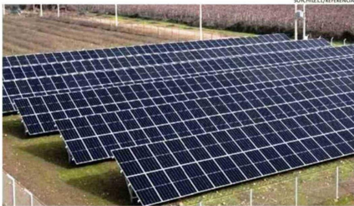
CAÍDA DE INICIATIVA PARA PUERTO MONTT ENCENDIÓ LA ALERTA EN LA REGIÓN.
