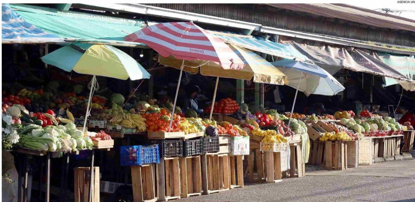
LA FERIA PEDRO AGUIRRE CERDA SERÁ MEJORADA INTEGRALMENTE, LO QUE CONSIDERA EL CAMBIO TOTAL DEL TECHO, ALCANTARILLADO, ILUMINACIÓN, PINTURA, FACHADA, ENTRE OTROS ASPECTOS QUE HOY LUCEN MAL.
