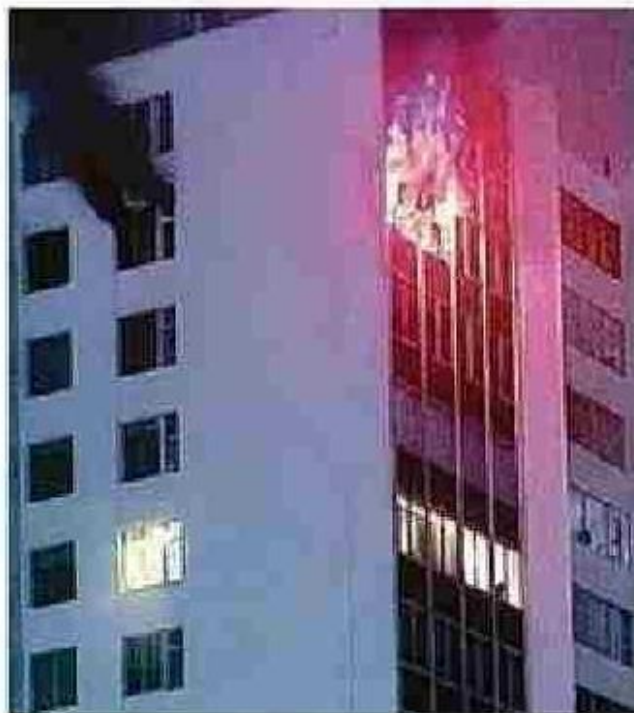
FUEGO SE CONCENTRÓ EN PISO 17.
